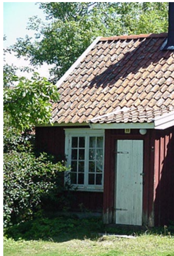
Bagarbod, öns äldsta byggnad, byggd 1800 foto Marianne Kindgren
